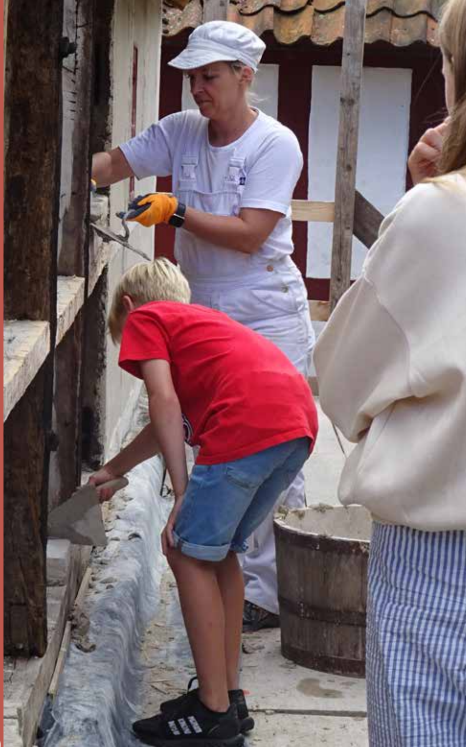
Gæsterne blev inviteret til at hjælpe med at mure tavl i bindingsværket.
